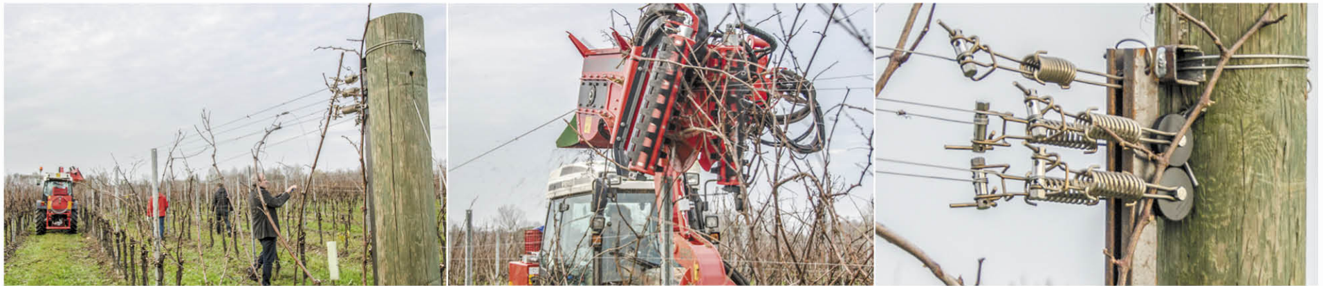
Limpieza mecanizada en una plantación con Dynamic interno.
