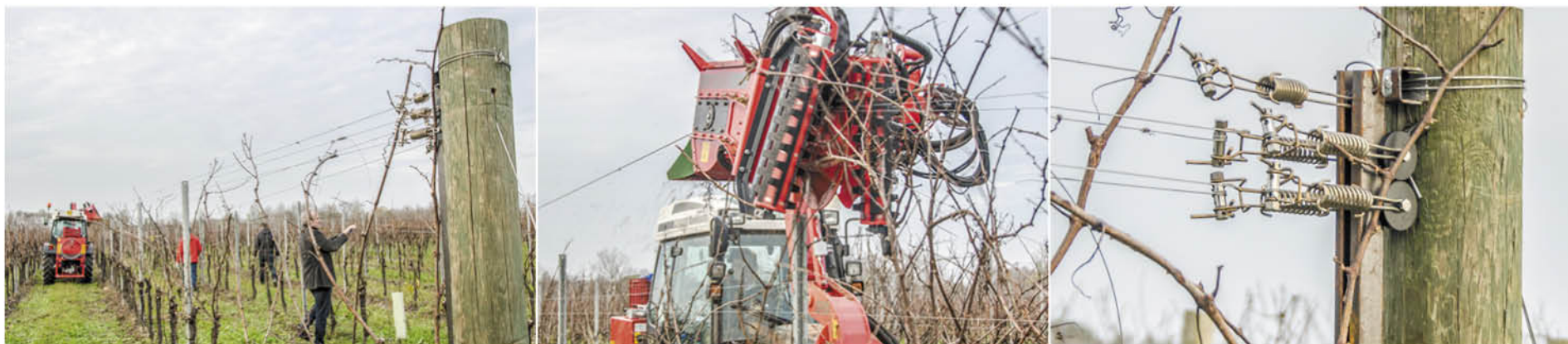
Limpieza mecanizada en una plantación con Dynamic interno.
